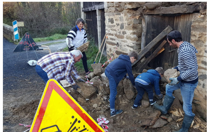
Mise en sécurité et nettoyage du Cortal
